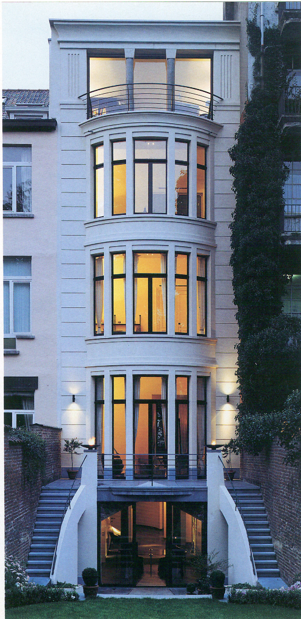
Façade arrière après travaux
