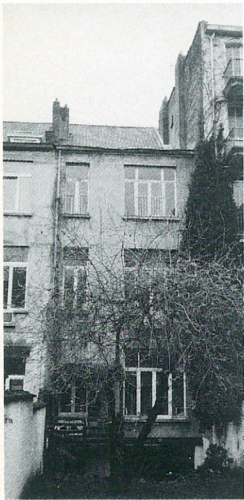
Façade arrière avant travaux
